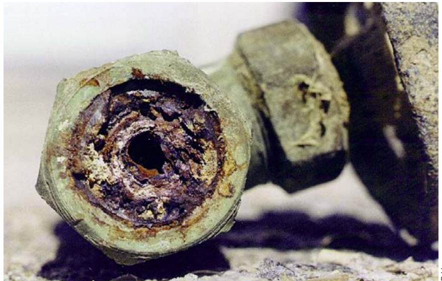
Fig.81.34: L'encrassement des conduites modifie le débit de l'eau.
