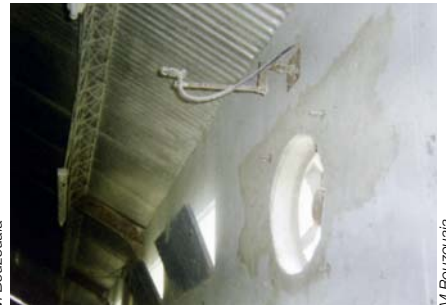
Fig.7.15: Système de nébulisation à basse pression.
