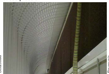
Fig.7.17 & 7.18: Échangeur d'humidité (cooling). Aspect vu de l'extérieur avec récupération partielle de l'eau et détail du côté intérieur.
