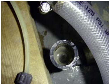
Fig.81.12 & 81.13: La couche de biofilm doit être décollée du système d'abreuvement.
