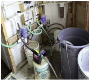
Fig.81.20: Les pompes submersibles peuvent être utilisées pour la distribution de concentrations adéquates de détergent dans les canalisations.
