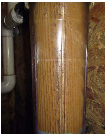
Fig.81.30: Filtre avec des dépôts.
