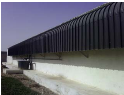
Fig.7.17 & 7.18: Pared evaporativa. Apariencia exterior con recuperación parcial de agua y detalles adentro.
