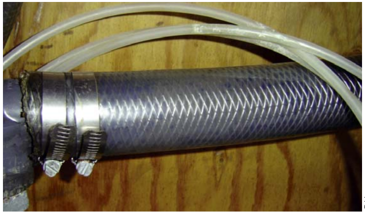
Fig.81.11: Inicio de biofilm en nuevos equipos.
