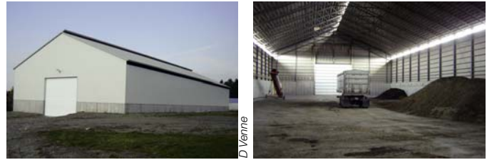
Fig.8.2 & 8.3: Almacén de gallinaza en Canadá. Aspectos interior y exterior.
