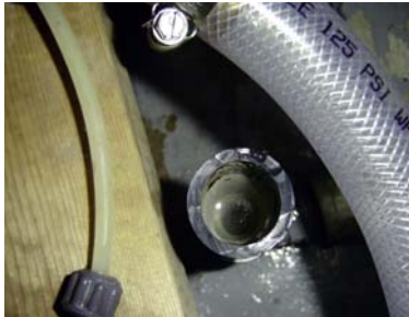
Fig.81.12 & 81.13: La capa de biofilm deben pelarse fuera del sistema de bebederos.
