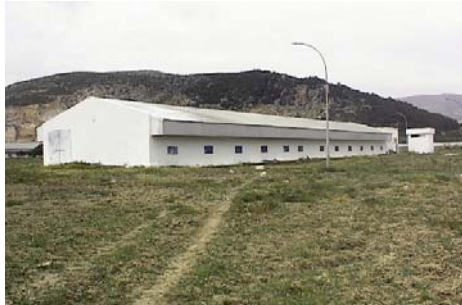
Fig.7.13: Caseta cerrada con ventilación dinámica lateral.
