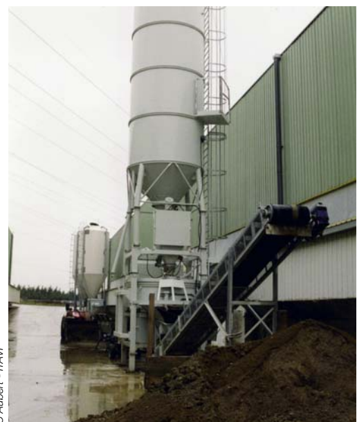
Fig.8.11: Instalación de encalado de estiércol de gallinas ponedoras.
