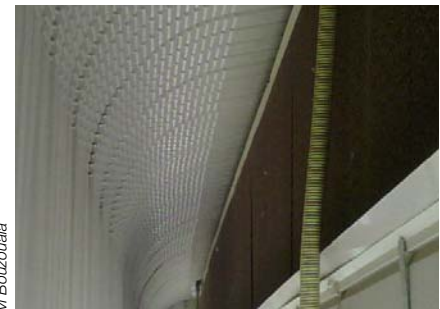
图7.17 & 7.18: 水帘冷却装置。进行部分水回收的外部以及内部细节。
