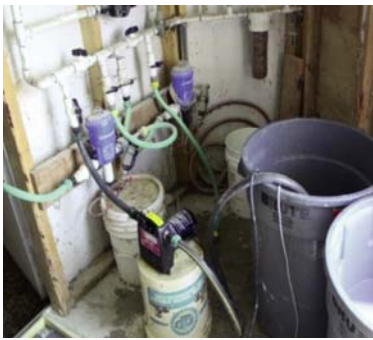
图81.20: 潜水泵可以被用来将适当浓度的管线清洁剂注入供水系统。
