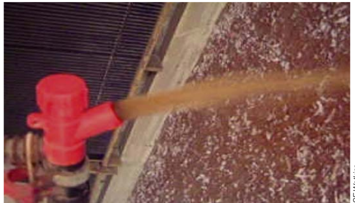
图81.15 & 81.16:不是所有的产品都能有效地去除生物膜。左图的管道中填充了弱酸，但和右图相比，该解决方案没有除掉任何杂质。在右图中，将含稳定剂的50%过氧化氢稀释成3%溶液进行清洗来破坏和除去这些管道中的生物膜则更加有效。
