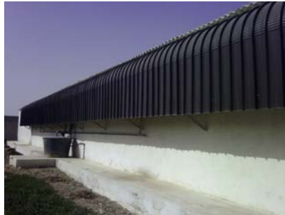
图7.17 & 7.18: 水帘冷却装置。进行部分水回收的外部以及内部细节。
