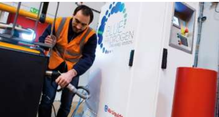
Station hydrogène pour chariots élévateurs dans l'entrepôt logistique de Prelocentre à Orléans (France)
