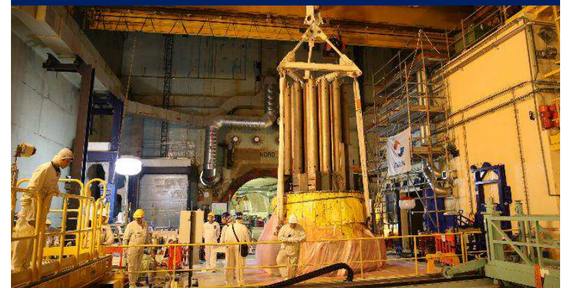
Découpe des internes de cuve sous eau
