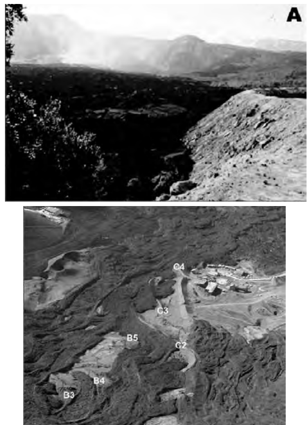
Fig. 2 : Contrôle des coulées de lave. Barrages de terre, orthogonaux ou transversaux au front de la coulée. En haut (1991-1992), l'avancée de la lave a été retardée d'un mois. En bas (2001), la lave a été déviée vers un trajet moins destructeur.
