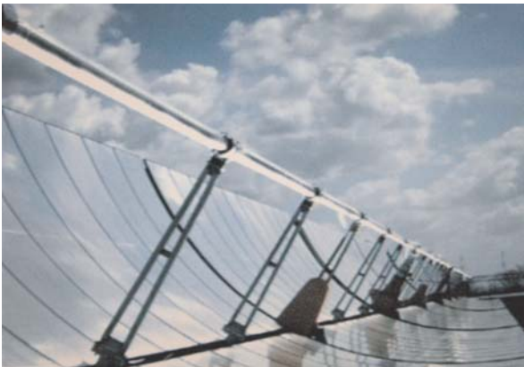
Fig. 6 : Le tube récepteur de chaleur
