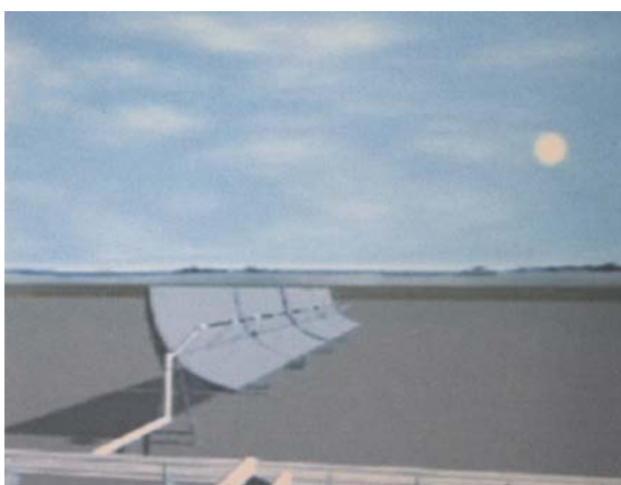
Fig. 3 : Technologie cylindro-parabolique de captage de l'énergie solaire
