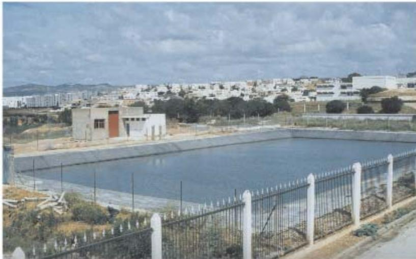
Fig. 5 : Étang solaire de l'ENIT (1 500 m<sup>2</sup> x 3 m) Température maximum atteinte en juillet 2001 : 97 °C.
