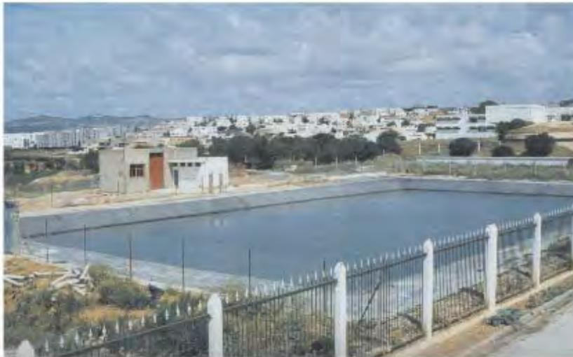
Fig. 5 : Étang solaire de l'ENIT (1 500 m<sup>2</sup> x 3 m)
